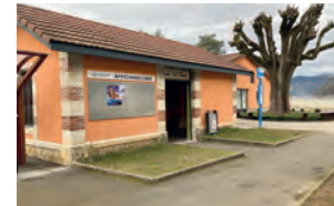
abris bus rue du Tram
