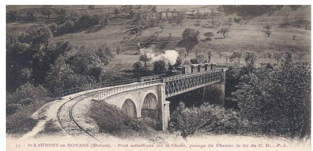
Le pont du Tram anciennement en service
